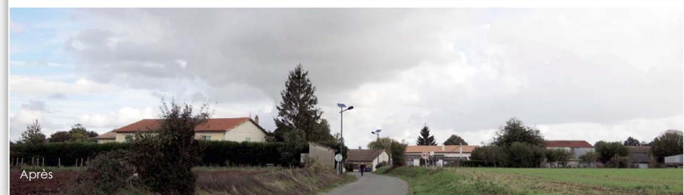
Exemple de mesure de compensation : Enfouissement de la ligne moyenne tension et de l'installation de lampadaires
