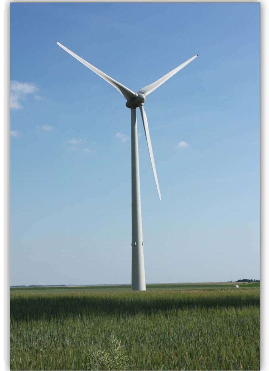
Photographie d'une éolienne de la gamme ENERCON
