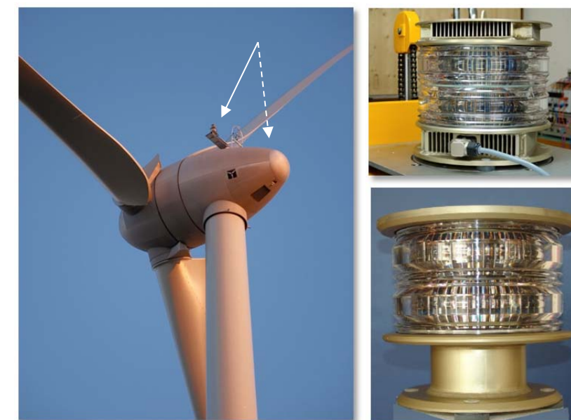
Balisage d'une éolienne ENERCON
